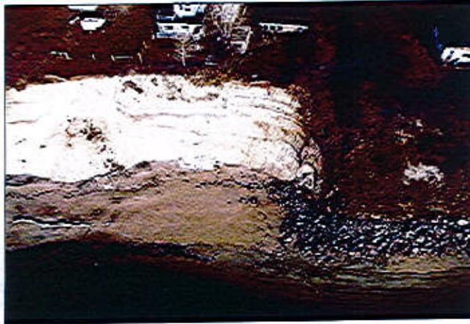
Figure 3 – Travaux d'envrochement et effet de bout (Photo : MSP, 2000)
