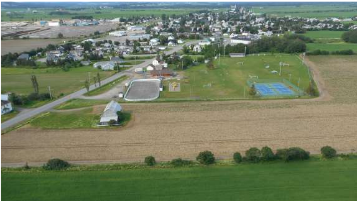
Zone 7 (rue Saint-Pierre) d'est en ouest
