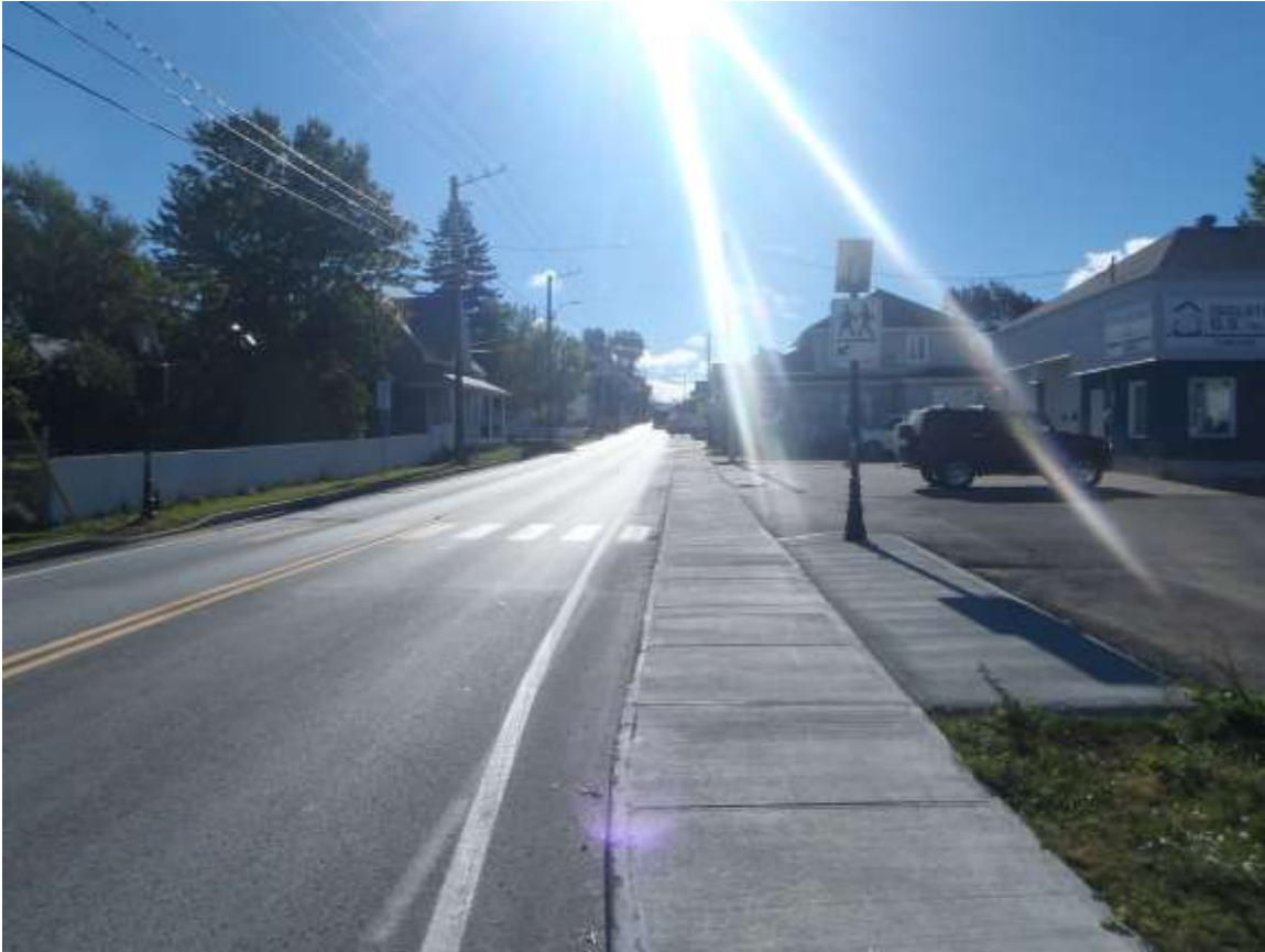
Route 298 (rue Saint-Alphonse) dans Luceville, juste au sud de l'intersection de la rue Saint-Pierre : chaussée refait à neuf, trottoir refait, signalisation de la traverse-piétonne améliorée et accotement asphalté d'environ 0,5 mètre
