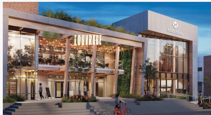
Centre d'innovation agroalimentaire L'Ouvrage, Trois-Rivières
